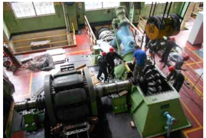
පැරණි ලක්ෂ්‍යාන බලාගාරයේ ජෙනරේටරයේ සහ ටර්බයිනයේ කොටස් ගලවා ඉවත් කිරීම
