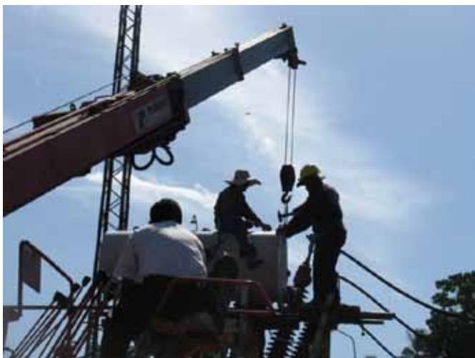
බදුල්ල කොටුම්භ උපපොලෙහි තරාපැට් දෙකේ හානියට පත් තෙල් ආරක්ෂණයෙහි (conservator) අළුත්වැඩියා කටයුතු
