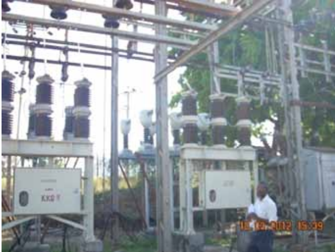
යාපනයේ, උතුරු ජනහි බලාගාරයේ විදුලි උත්පාදනය බෙදාහැරීම සඳහා කිලෝවෝල්ට් 33 පෝෂක මර්ග සැපයීම
