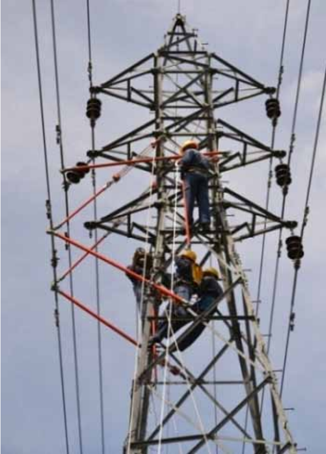
කිලෝවෝල්ට් 33 කුළුණු රැහැන්වල සජීවී රැහැන් නඩත්තු කටයුතු
