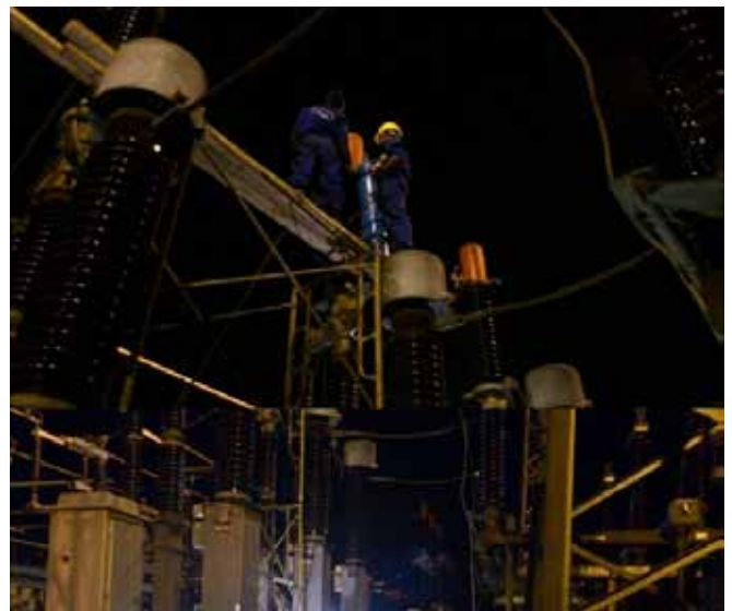
බදුල්ල - අම්පාර විදුලි සැපයුම් මාර්ගයේ කිලෝවෝල්ට් 145 පරිපථ බිඳුමේ අලුත්වැඩියාවන්
