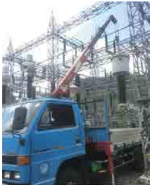
රූපය සම්.10: උකුවෙල ජාල පොළෙහි කි.වෝ. 132 ධාරා තරාපැවිය මාරු කිරීම
