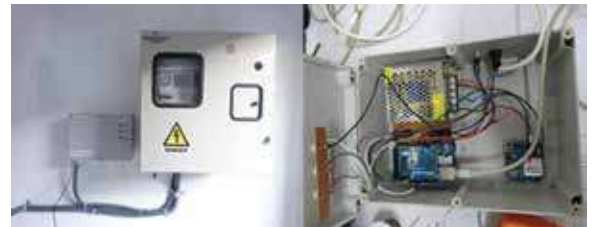
රූපය C 7: ස.නො.පු.බ. විදුලි බලාගාරයක සවිකර ඇති සන්නිවේදන උපකරණය
