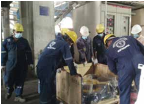
රූපය A 8: ලක්විජය විදුලි බලාගාරයේ අංක 02 දරන බොයිලරුවේ සෝපානයේ ඇදුම් මෝටරය මාරු කිරීමේ කටයුතු
