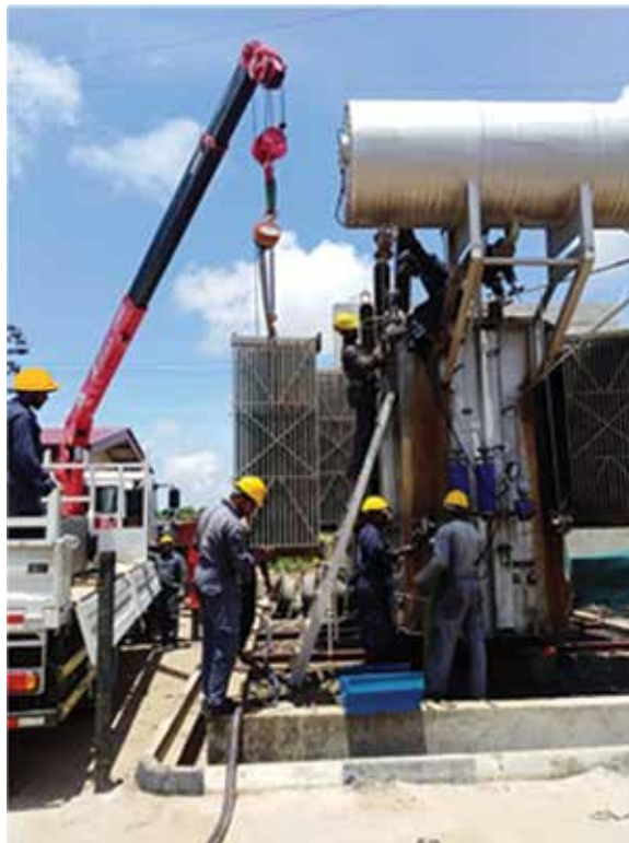
රූපය T 16: මාදුම්පේ කොටුමා උපපොළෙහි තරාපැව් ගෘස්කට් මාරු කිරීම
