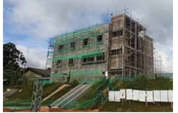
உரு P 11: பியகம 220/33 kV GS இல் கட்டுப்பாட்டு நிலையக் கட்டடத்தின் நிருமாணம்
